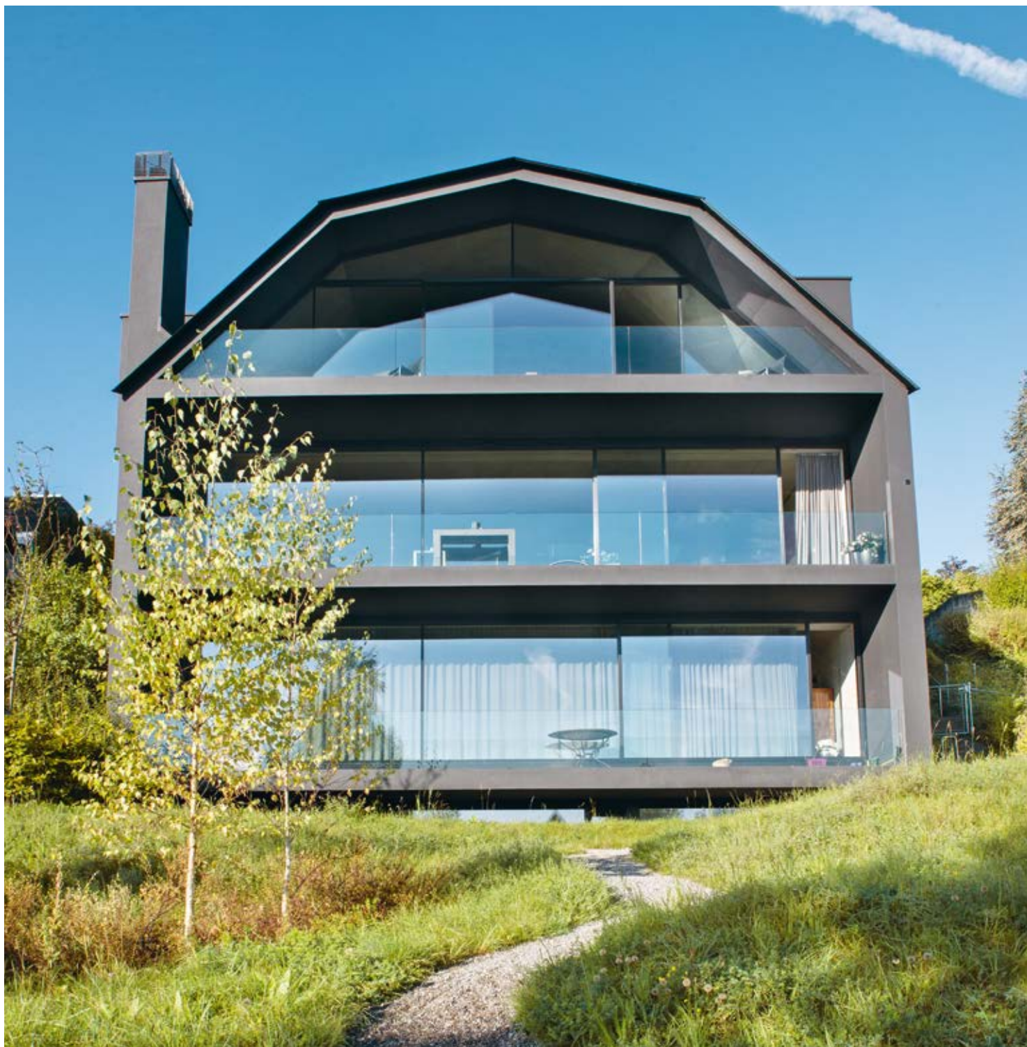
Der Minergie-Bau umfasst drei Wohneinheiten.
